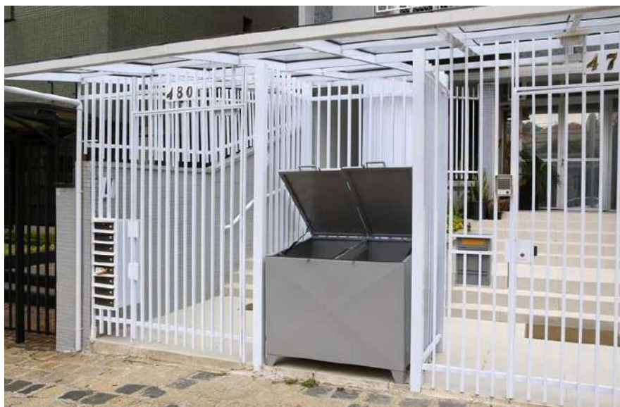
Figura 47 – Exemplo do posicionamento correto do coletor (es)
