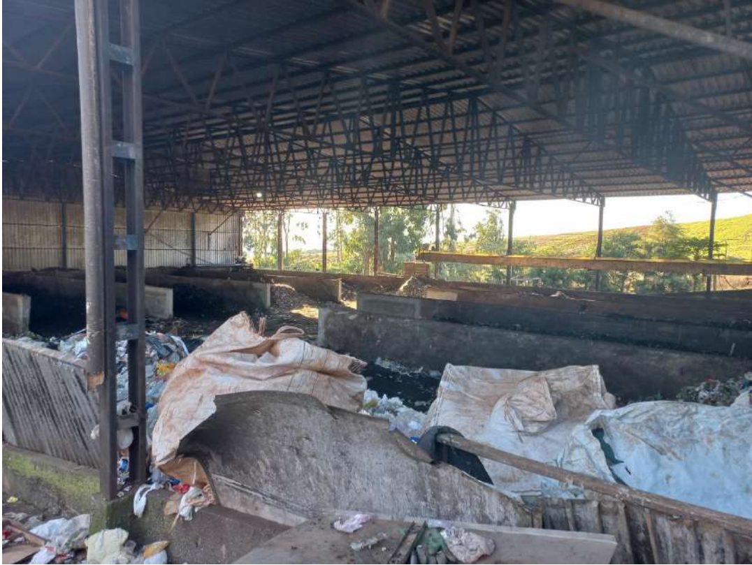
Figura 26 – Pavilhão da compostagem e armazenagem dos rejeitos
