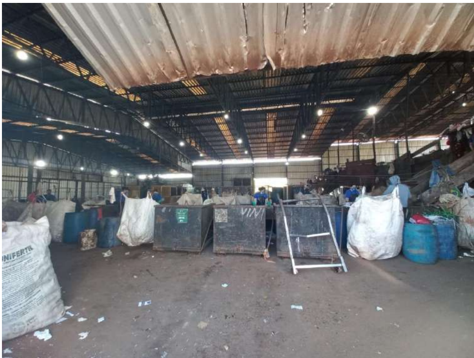
Figura 25 – Pavilhão de recebimento das resíduos e de triagem, onde ficam as três esteiras de triagem dos resíduos
