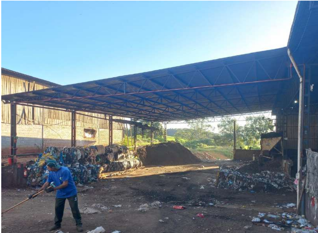
Figura 28 – Pavilhão de armazenagem 1
