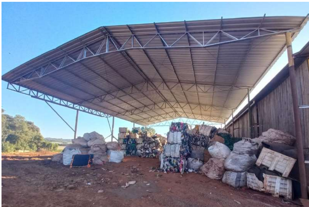
Figura 29 – Pavilhão de armazenagem 2
