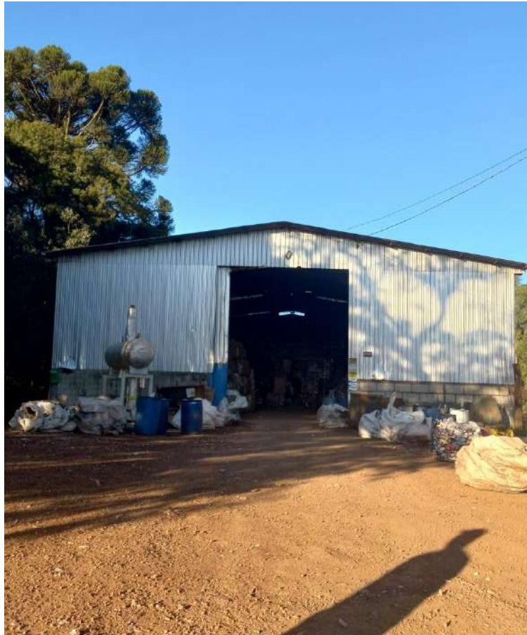
Figura 30 – Pavilhão de armazenamento 3
